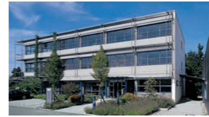
Development centre in Germany Centre de développement en Allemagne Entwicklungszentrum in Deutschland
